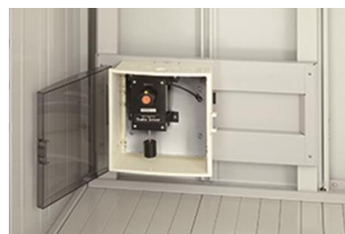
地震解錠装置のクエイクセンサー（機械式地震感知器）
