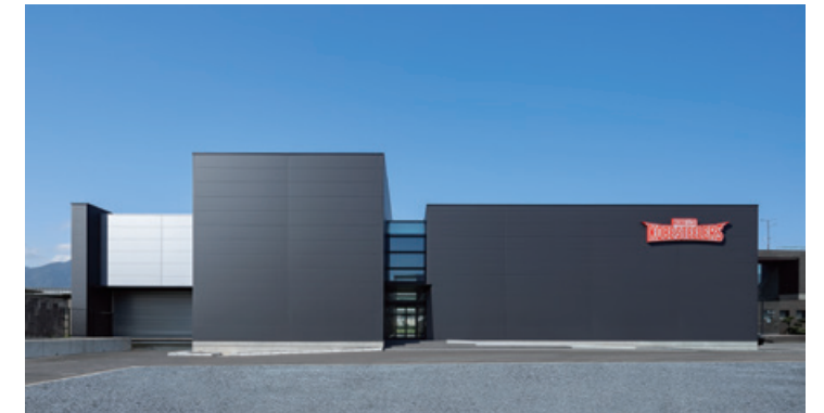
「ヨド耐火パネルグランウォール施工例」(コベルコ神戸スチラーズ灘浜クラブハウス)
