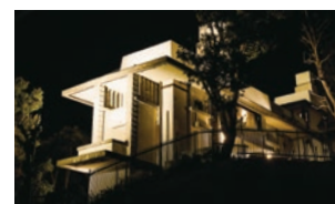
LED化されたライトアップ照明
