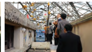
工事見学会の様子
