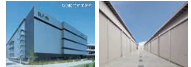
ヨド耐火パネルグランウォールを使用した施工事例 GLP吹田
