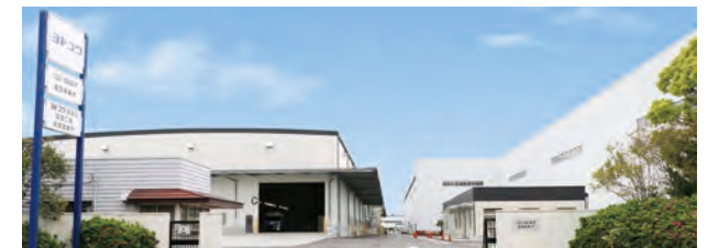
姫路事業所「ヨド耐火パネルグランウォール」生産工場
