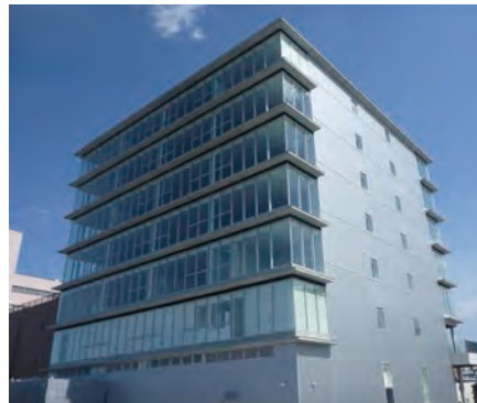
「ヨド耐火パネルグランウォール」施工例 物件名：南海和歌山市駅オフィビル棟
