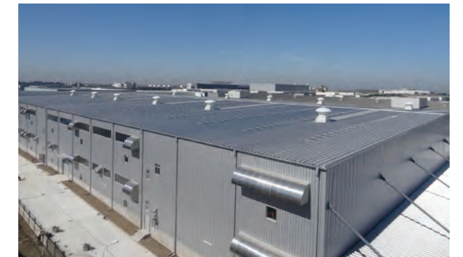
YBMH社(中国) 施工例 屋根66H 外壁806型 物件名:日立物流(天津)第二倉庫新築工事
