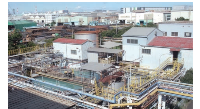
市川工場 総合廃液処理設備
