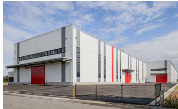
水島鉄工(株) 安田工場
