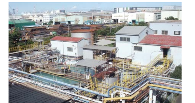
市川工場 総合廃液処理設備
