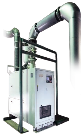
市川工場 No.3めっきラインターボブロワー更新 高効率機器の導入により、CO 2 の削減に貢献しています
