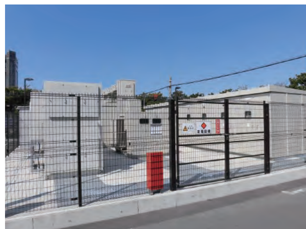
泉大津工場 受電変電設備の更新
