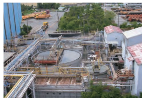
市川工場 総合廃液処理設備
